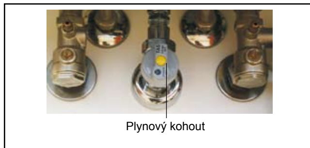
Obr. Uzavírací ventily
