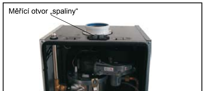
Obr. Měření spalin při otevřeném kotli
