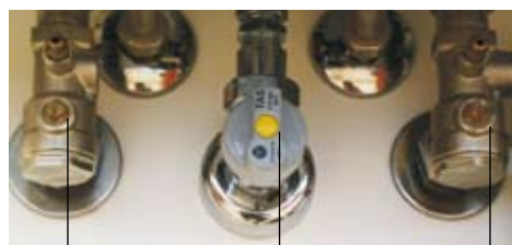
uzatvárací ventil prívodu
