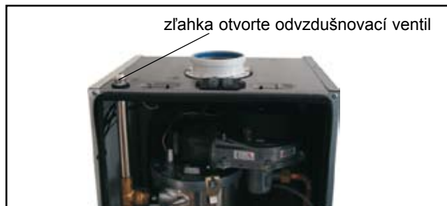
ručný odvzdušňovací ventil
