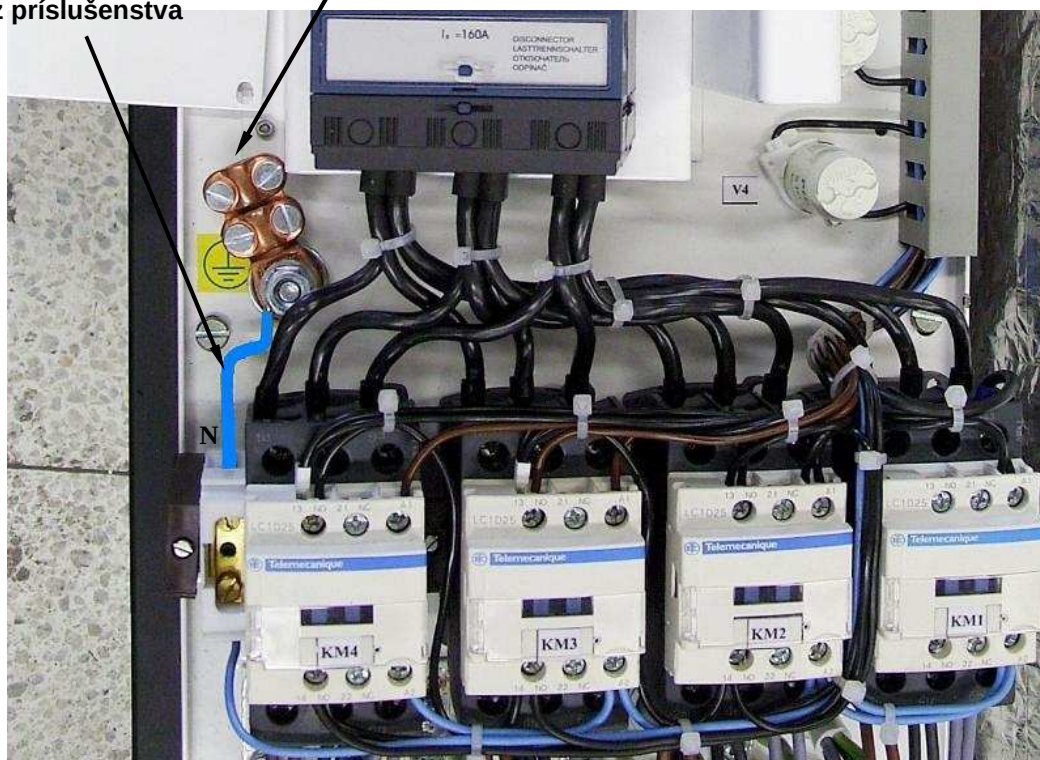
Obr. 24 Pripojenie ochranného vodiča prívodného kábla kotla Daline PTE (22-)36-60 (štvorvodičová sieť)
