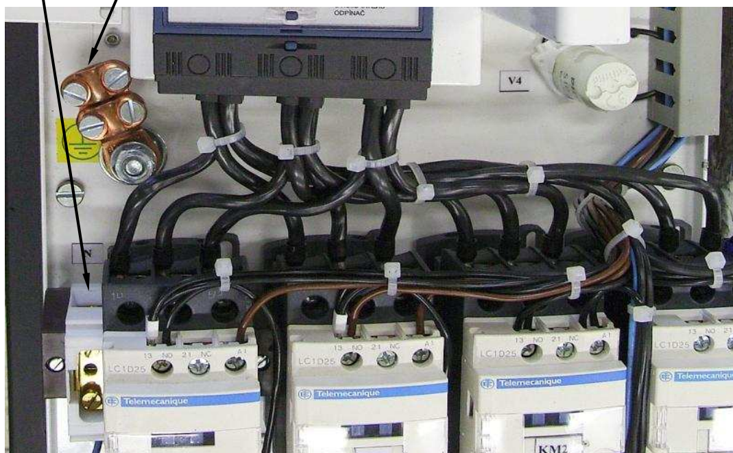
Obr. 23 Pripojenie ochranného vodiča prírodného kábla kotla Daline PTE (22-)36-60 (päťvodičová sieť)
