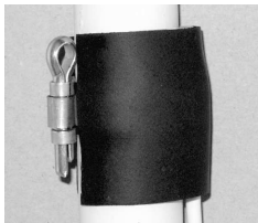
Izolace čidla termoizolační páskou
